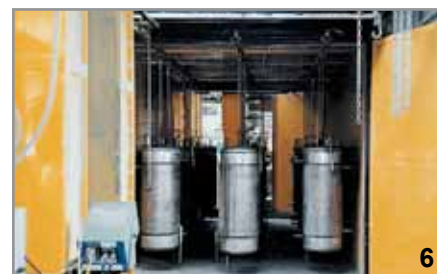
Φούρνος ψησίματος των δεξαμενών.
